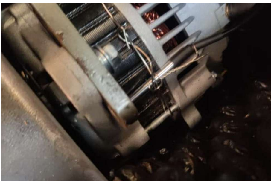
Temperatursensor på generatorn.
